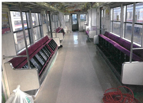
電車車両の内装工事
