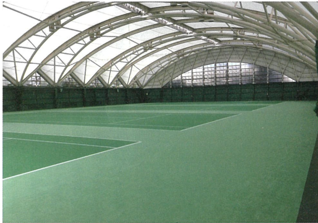
サーフェスとラインが1枚になったようなカーペット施工
