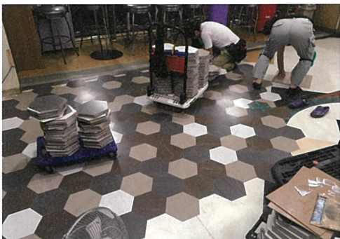
室内内装工事
